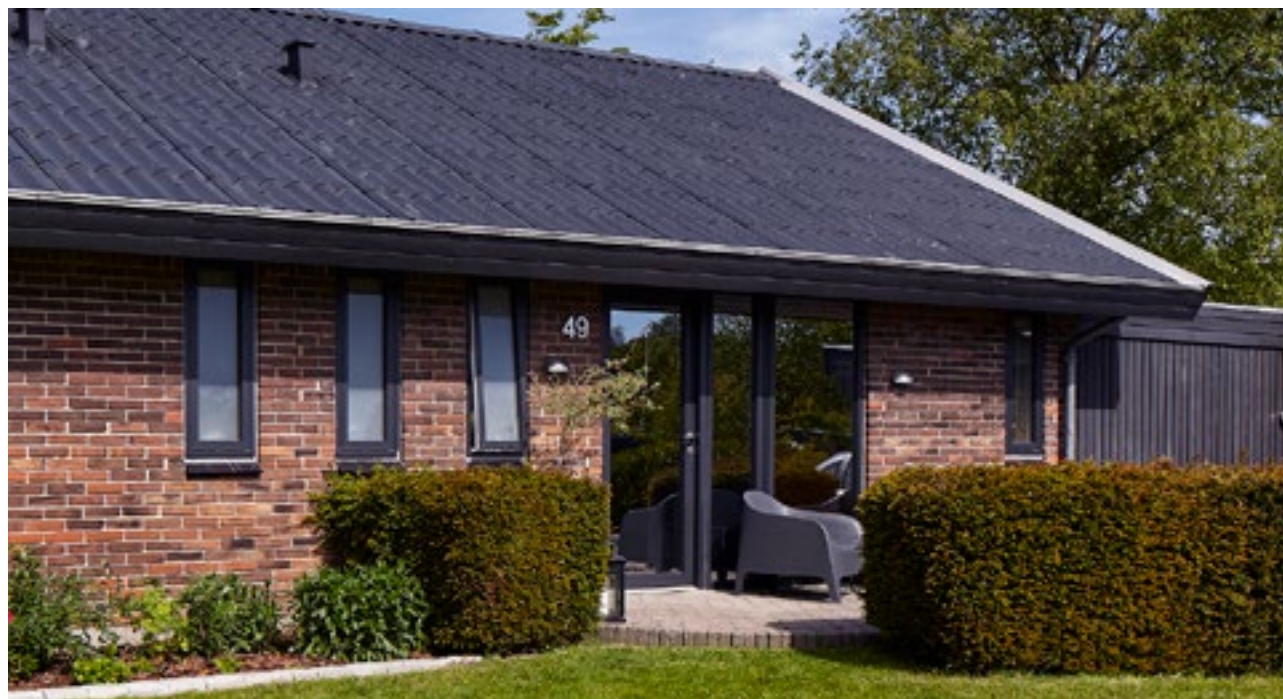
Satinglas i vinduerne til venstre, og solglas i dørpartiet af typen 'Solar Silver'. Dette glas er reflekterende og dermed hindrer indkig.
