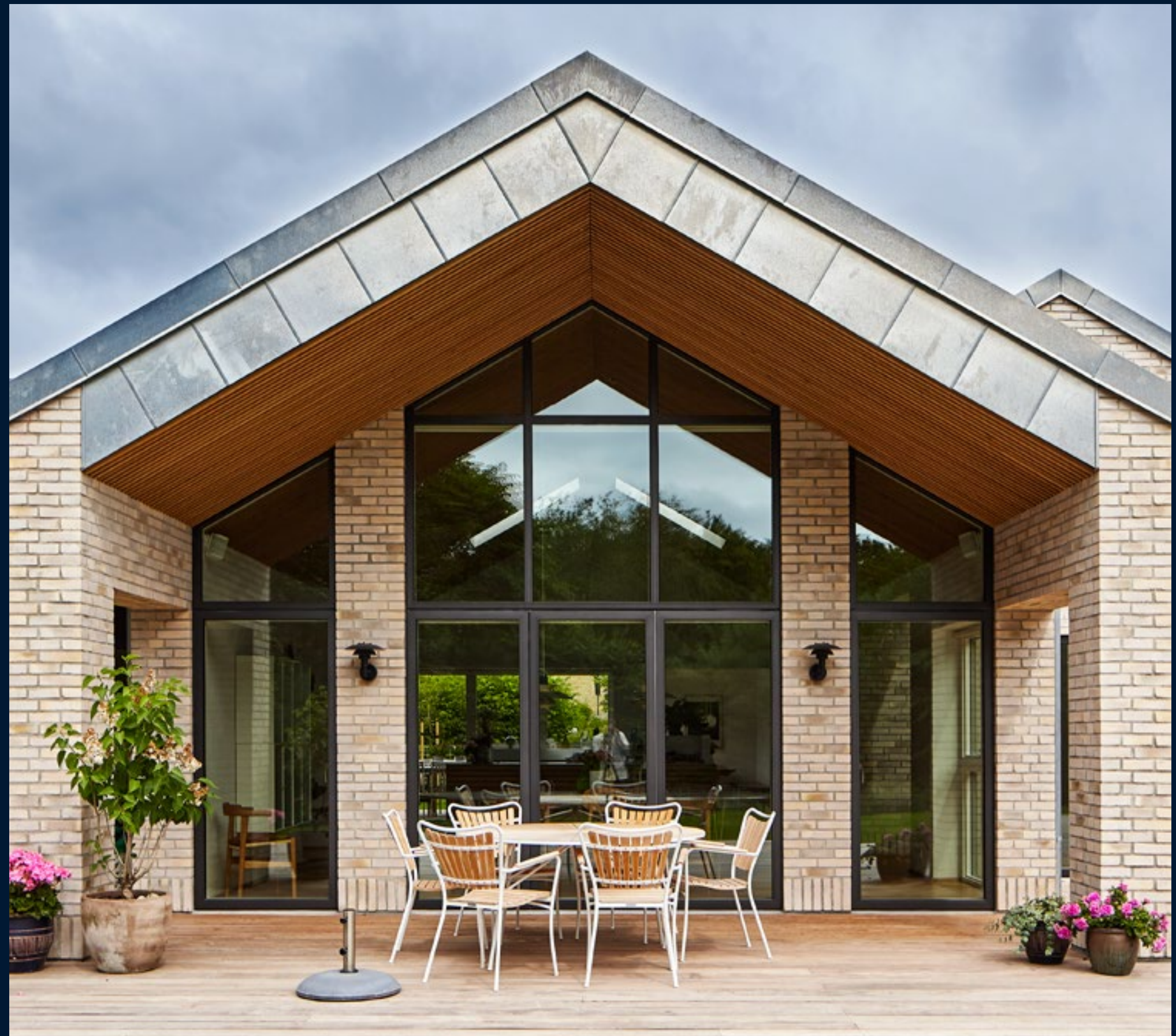
Træ/Alu Daylight elementer bygget til kip
