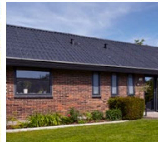
70'ER PARCELHUS med topstyrede vinduer
