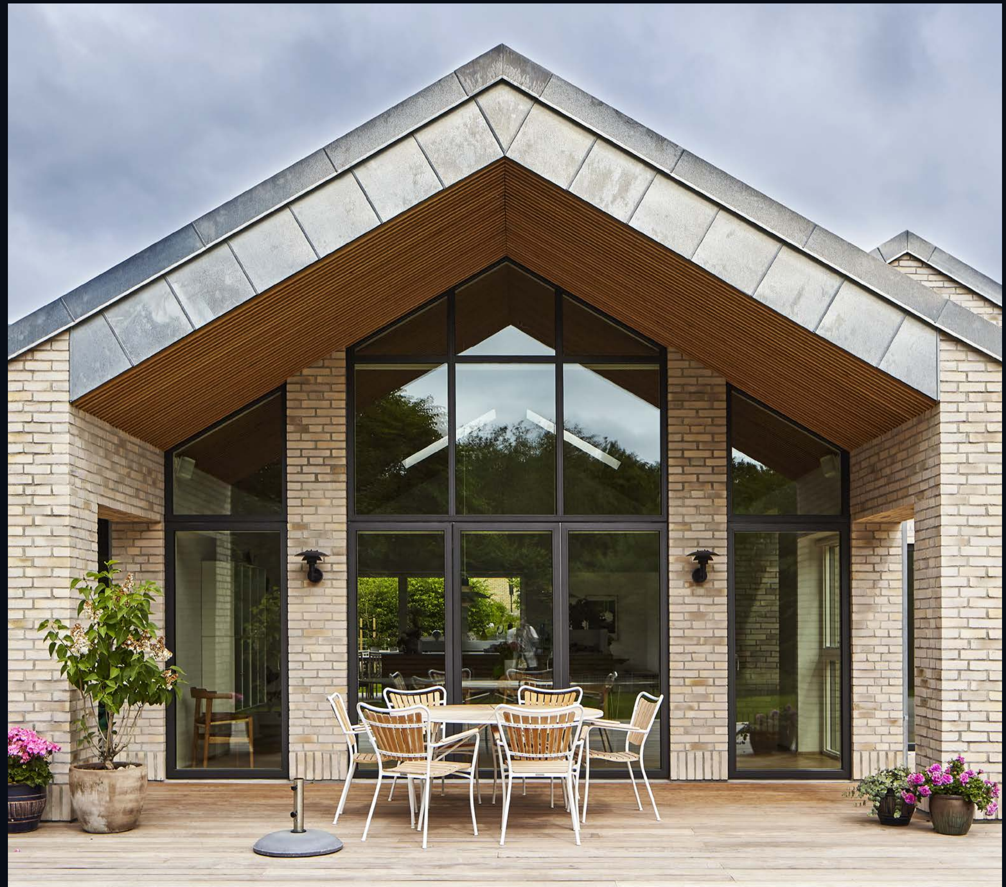
Træ/Alu Daylight elementer bygget til kip
