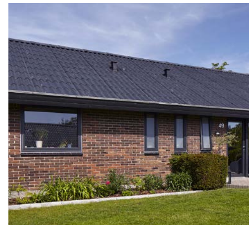
70'ER PARCELHUS med topstyrede vinduer
