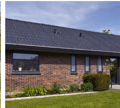
70'ER PARCELHUS med topstyrede vinduer
