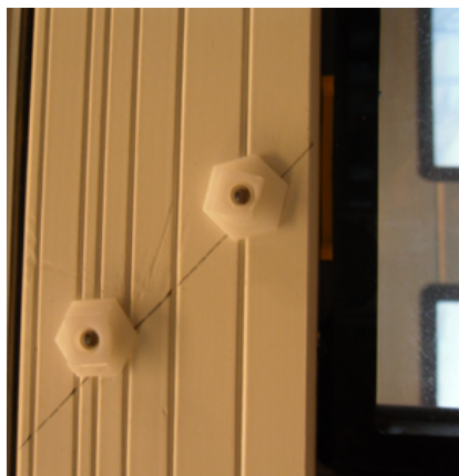
9. Udskift evt skadede eller løse clips.
