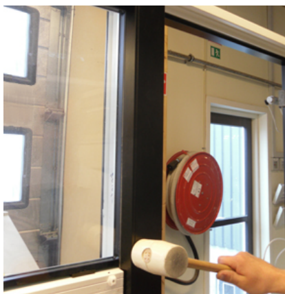
12. Aluminiumsrammen slås fast på clips med gummihammer med lette slag.
