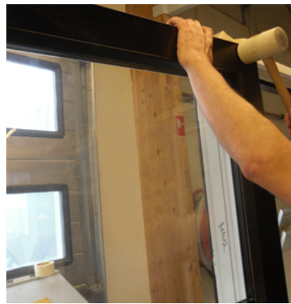
11. Aluminiumsrammen holdes på til den falder på plads på clips.
