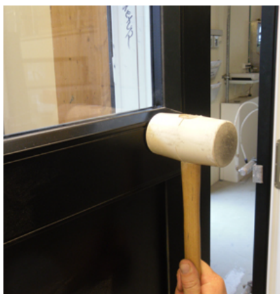
13. Tapstykket slås efterfølgende fast med gummihammer.
